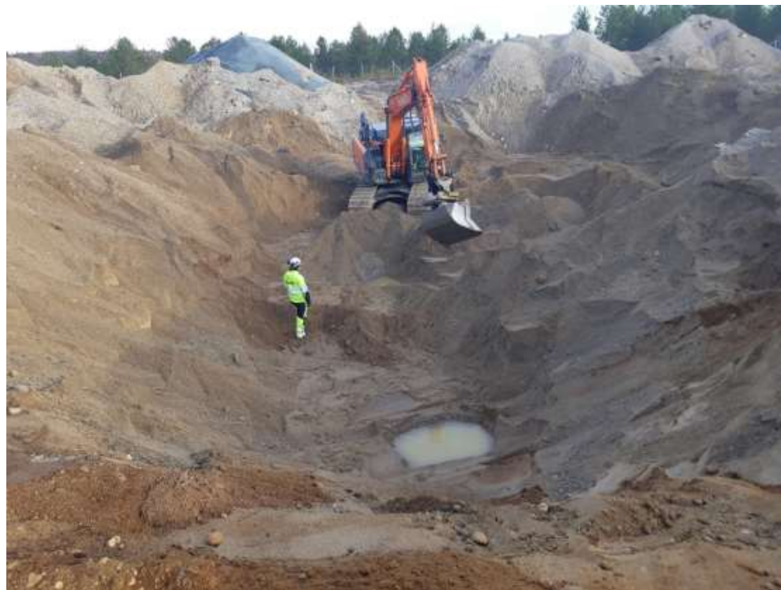
Kuva 9. Inarin Näätämön vanhan jakeluaseman maan kunnostustyöt vuodelta 2021.
